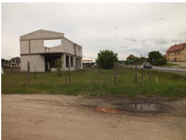
15. Widok na budynek w stanie surowym otwartym zlokalizowany przy drodze wojewódzkiej nr 196
