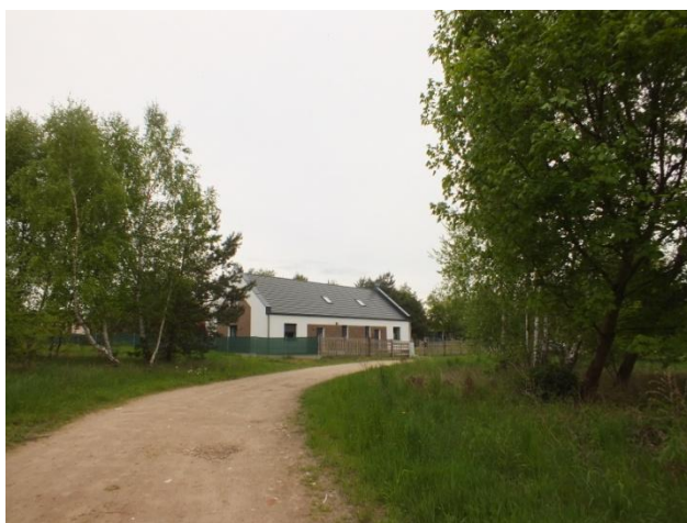
20. Widok na budynek mieszkalny zlokalizowany przy ulicy Fioletowej
