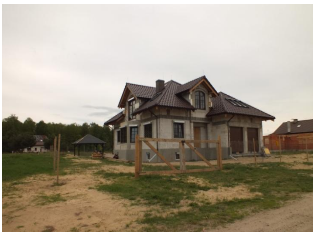
17. Widok na budynek mieszkalny jednorodzinny zlokalizowany przy ulicy Fioletowej
