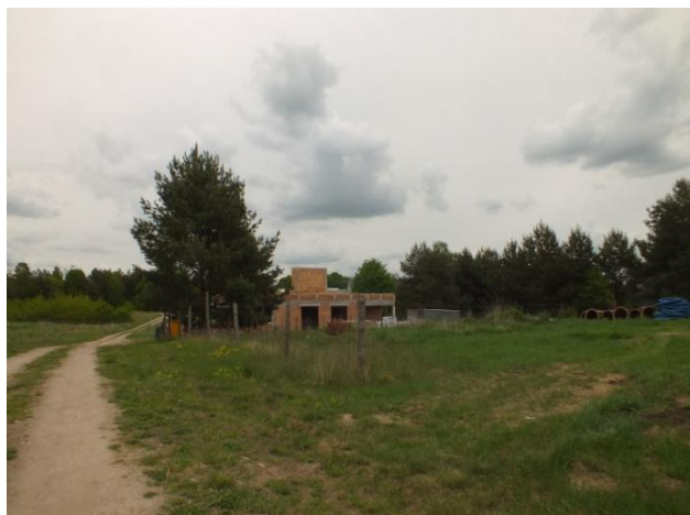
4. Widok na teren, na którym prowadzone są roboty budowlane, zlokalizowany przy ulicy Żółtej
