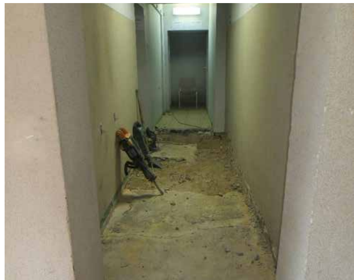
Prace rozbiórkowe łazienki dla sędziów. Fot. A. Nowakowski
