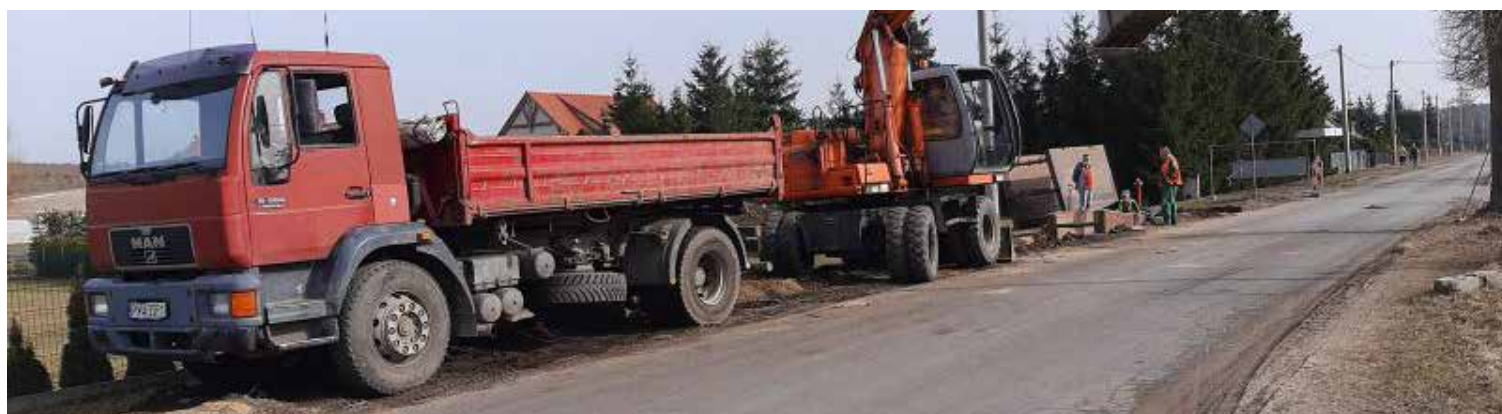
Wykonawca ma zakończyć roboty najpóźniej w sierpniu tego roku. Fot. wagrowiec.pl
