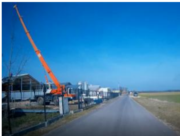
36. Widok z drogi gminnej na kurniki
