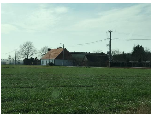
25. Widok z drogi gminnej na zabudowę zagrodową
