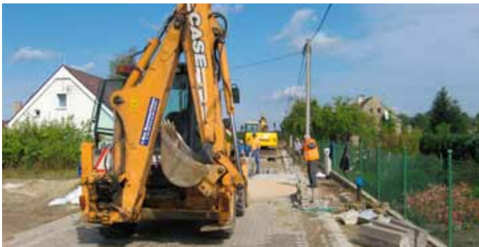
Budowa ulicy Kościuszki w Skokach.
