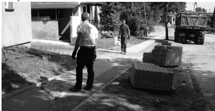
Budowa chodnika w Lechlinie
