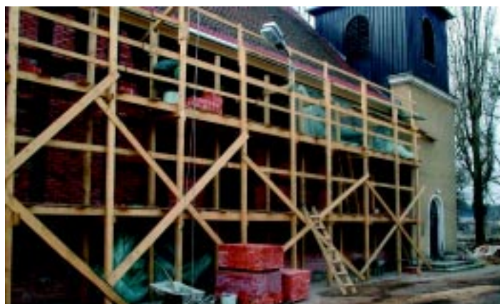
Drewnianą konstrukcją murów kościoła pw. Mikołaja Biskupa wypełniła cegła.
